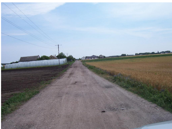
KM 0+100 Szerokość jezdni 4,4m
