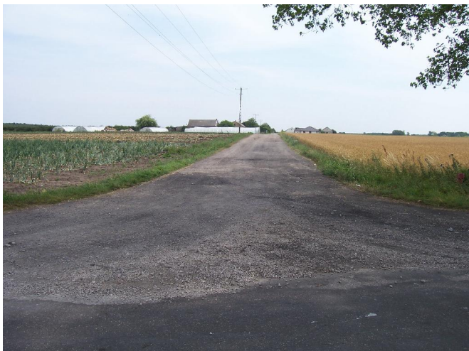
KM 0+000 początek trasy Szerokość jezdni 5,20m; R=5m
