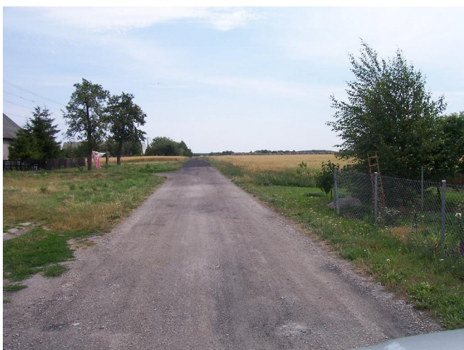
KM 0+400 Szerokość jezdni 3,8m
